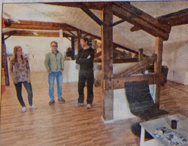
Vinden var tidigare oinredd. Nu är det moderna kontor. De stora bjälkarna har bevarats och är original.
